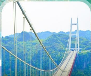
สะพานอ้ายจ้าย
